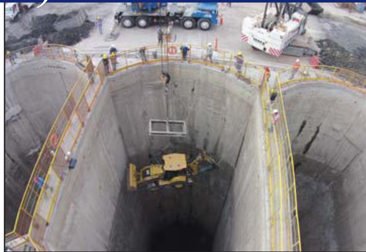
El proyecto "Sistema Riachuelo" en obras.
